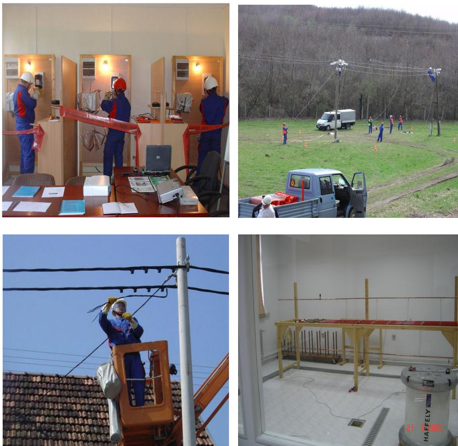
Slika 16: Prikaz DPN na NN na poligonu za usposabljanje v HEP NOC in na terenu
