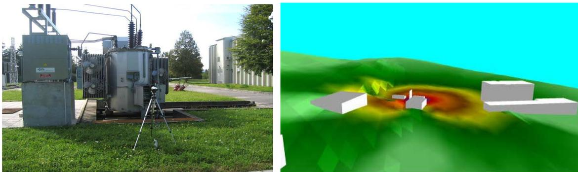
Slika 40: Meritev hrupa v RTP in prikaz 3D-izračuna hrupa
